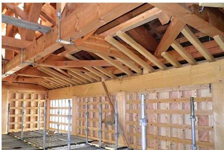
すべての壁が耐震補強格子壁。内部に90mm角木製面格子をはめ込み、その両面を12mm厚構造用合板でしっかり固定。
