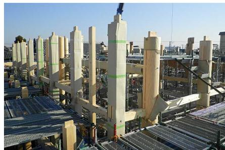
25 t ラフタークレーン登場。立柱の後、小屋組組付け。本堂中央に柱のない広い空間を実現するためトラス構造を採用。三角形が基本単位の構造形式で、屋根荷重すべてを横方向の力に変換する仕組み。
