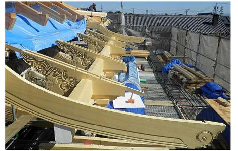
内陣屋根の最上部後方から大屋根を見た写真。右は野垂木(のたるき)左は野地板(のじいた)施工まで。ルーフィングの後、瓦葺き行程へ。★ 屋根中央が前方に張り出す部分=向拝(ごはい)には4本の向拝柱設定。
