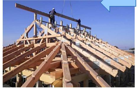
下屋根仕舞い。化粧材は耐水耐朽性の高い無節米ヒバを使用。★ 3つの屋根（大間(だいま)上の大屋根+内陣上の内陣屋根+華部屋・回廊・後堂上の下屋(げや)）を組み合わせたT字型撞木(しゅもく)構造。
