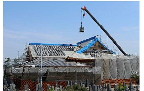
下屋(げや)は棧(さん)瓦葺き、大屋根と内陣屋根は一体型三州瓦を使用した本瓦葺き。土を使わない空(から)葺き工法を採用。またすべての棟(むね)には耐震棟を施工。
