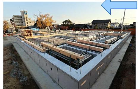
柱は全85本。直径450mm檜丸柱6本+ 桧角柱65本+ 桧丸柱14本。
