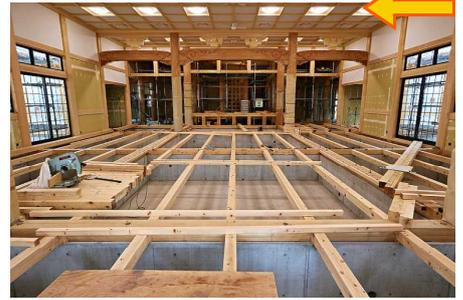
外陣(げじん)13畳+大間(だいま)78畳+土間(どま)14畳。基礎梁(はり)高850ミリで全床下収納。大引(おおび)きを鋼製束(こうせいづか)で支え24ミリ厚構造用合板を床全面に。天井高4.8メートル。自然換気式の化粧不燃石膏(せっこう)吸音ボードに8畳LEDシーリングライト42個設置。堂内を明るさと昼光・電球色で調光可能。
