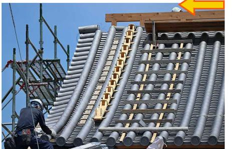
降り棟(くだりむね)と大棟(おおむね)の施工。写真は内陣屋根の西端部分。乾式耐震棟工法を採用。土や漆喰(しっくい)を使わず、瓦を下地材にビスで直接固定。軽量化と高強度、通気性を保有するのが大きな特徴。
