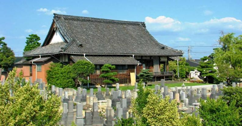
墓石が同じ大きさ見えるようにして比較。屋根高に大きな違いがないのは、日本堂下の土盛りを撤去し、参詣席床高比較で1.2m低く新本堂が建設されたため。床下空間確保のため、実際には3m近く地盤すき取り工事が行われました。
